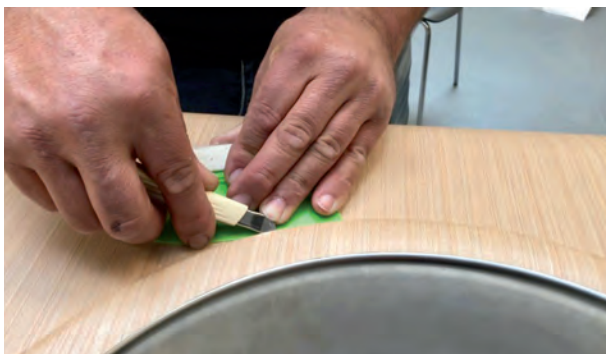
▲ Folie langs de wasbak afwerken en afkitten.
